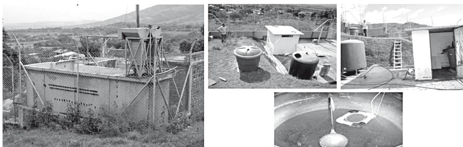
Fotografía 12.4 Planta compacta, fuera de servicio, y sistema de desinfección.
