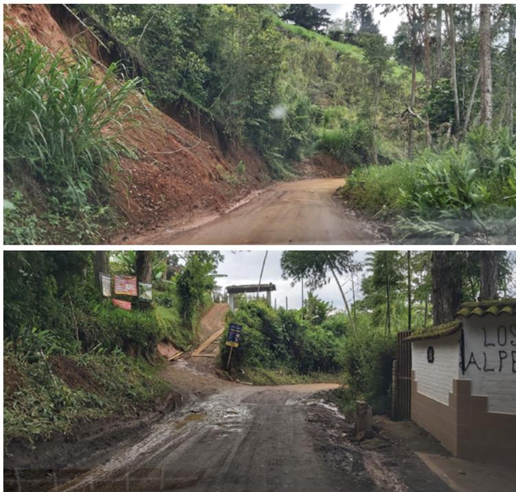
**Figura 15.** Deslizamientos y agua sobre la vía.
