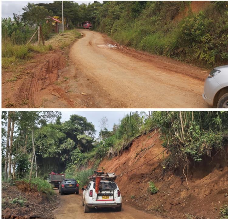
**Figura 14.** Tráfico pesado sobre el camino vecinal Tocatá-Simón Bolívar (Kilómetro 19).
