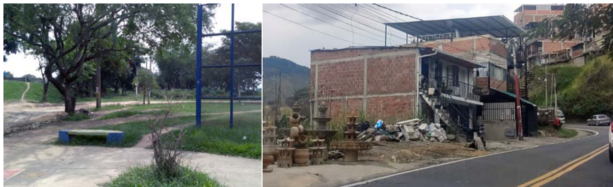
Figura 45. Vías de acceso a los barrios.
