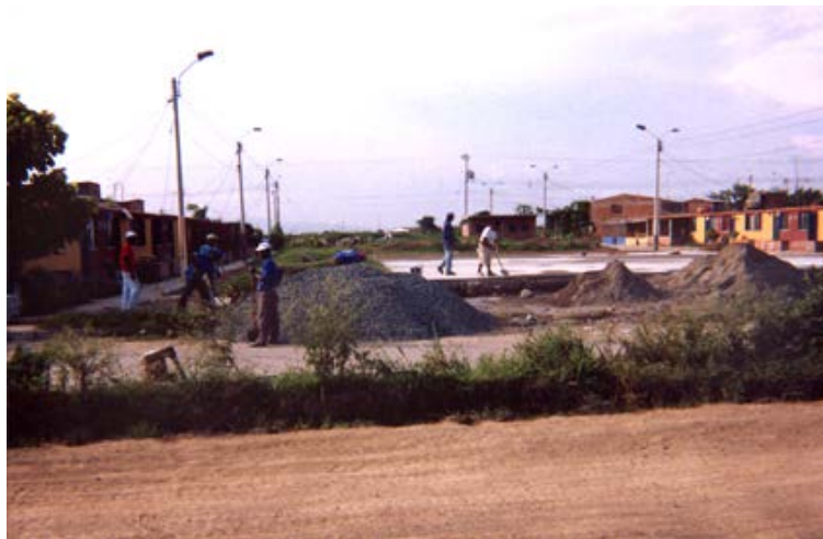
Figura 35. Construcción de equipamiento del barrio.
