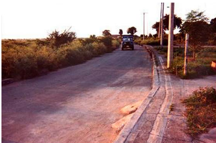
Figura 24. Una de las vías pavimentada.
