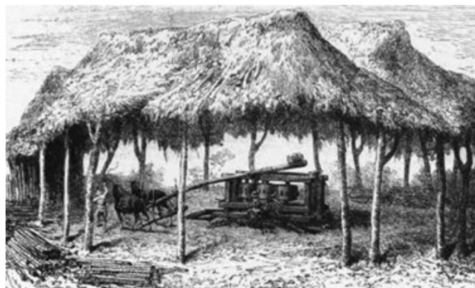
Figura 2. 1. El trapiche o molino de azúcar de tracción animal Fuente: Uribe y Perafán (2021)
