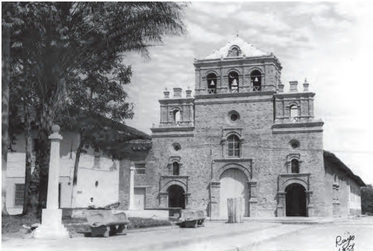
Imagen 24 Iglesia de Guadalupe en 1958 con los pañetes recién retirados. Fuente: Archivo fotográfico CHLAD - Foto Rayo
