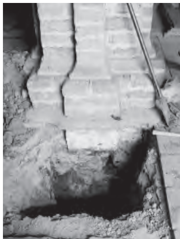
Imagen 68 Cimentación de pilastras en la nave central de la Iglesia
