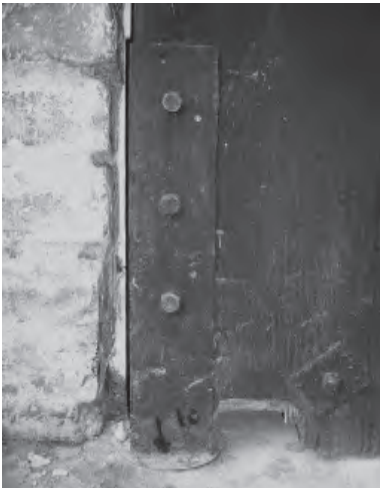
Imagen 64 Detalle del Gozne sobre el que giran la Puertas.
