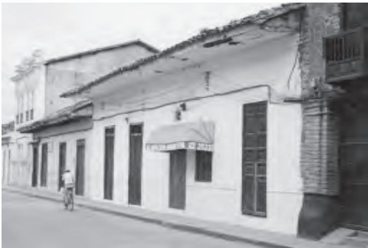
Imagen 9 La fotografía de esta casa fue tomada en 1989. En 1994 fue demolida y las huellas sobre las edificaciones vecinas permiten ver los muros maestros. Fuente: OSPINA - QUEVEDO
