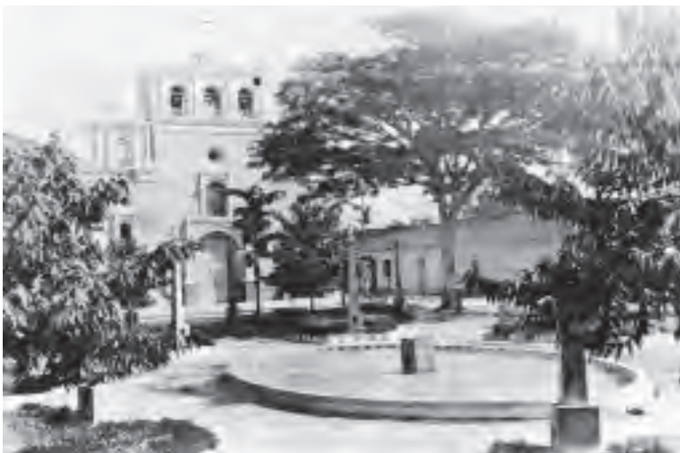
Imagen 26 En esta fotografía el muro bajo ya ha desaparecido, se conservan las luminarias y los prados se disponen geométricamente. Fuente: Archico fotográfico CHLAD
