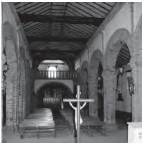
Imagen 56 Imagen del cielo en forma de falsa artesa que se observa desde la nave principal de la iglesia. Fuente: CITCE - Universidad del Valle.
