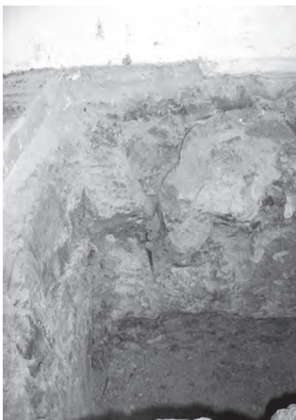
Imagen 104 Cimentación de Muros. Fuente: CITCE - Universidad del Valle.
