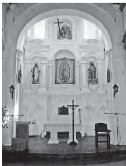
Imagen 60 Altar de la Nave Principal de la Iglesia. Fuente: CITCE - Universidad del Valle.
