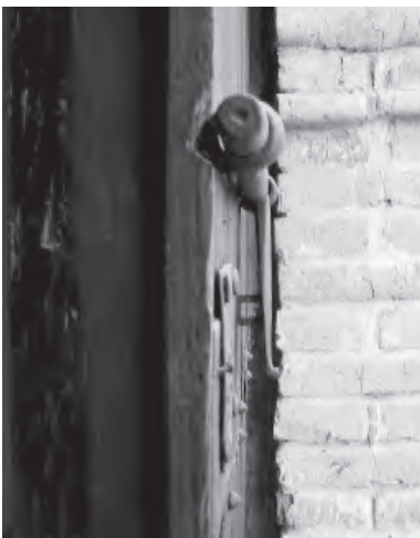
Imagen 65 Detalle de los pasadores que aseguran las puertas de acceso a la Iglesia.
