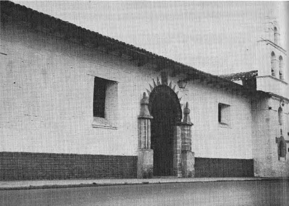
▲ Fachada Lateral. San Pedro. Buga.
