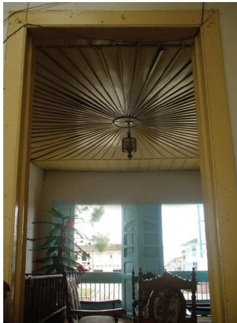
Carpinterías de cielos. Municipio El Cairo. Fotos: CITCE
