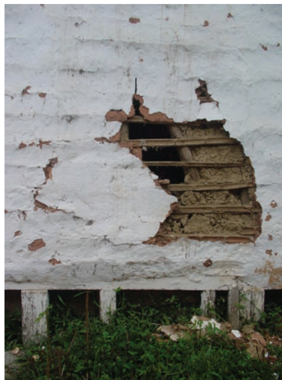
Marquesina y pared en bahereque. Municipio El Cairo. Fotos: CITCE
