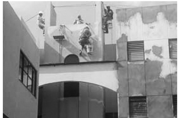
Figura 45. Reparación y mantenimiento de fachadas
