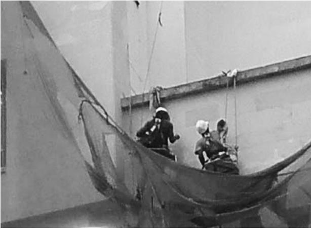
Figura 49. Redes de protección en el mantenimiento de fachadas
