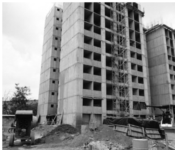
Figura 36. Edificio en construcción
