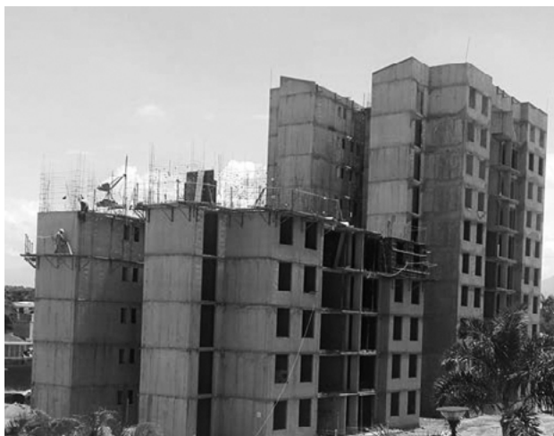
Figura 18. Proyecto en construcción
