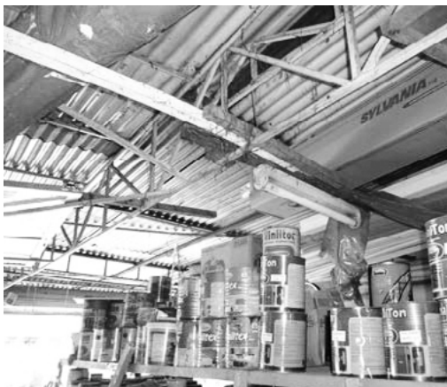
Figura 31. Almacén proveedor de materiales
