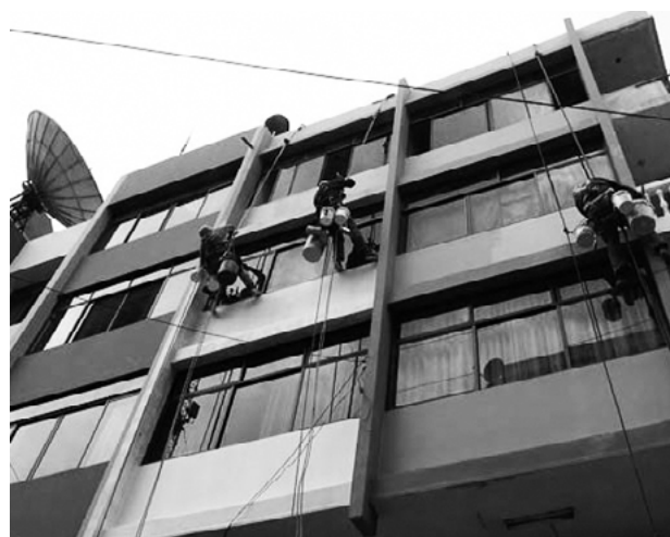
Figura 44. Trabajos de mantenimiento en fachada
