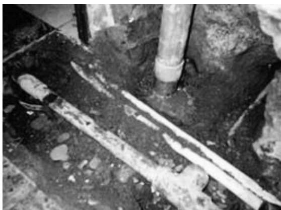
Figura 26. Daño hidrosanitario
