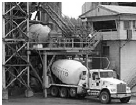
Figura 11. Envase y transporte de hormigón Fábricas de cemento Glacier Northwest, Kenmore, Washington
