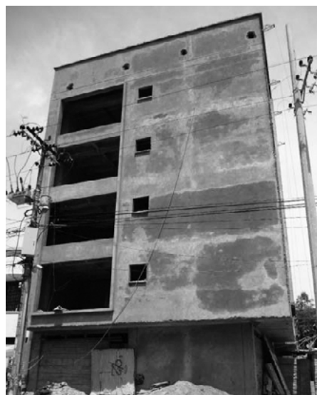
Figura 30. Fachada de edificio en construcción
