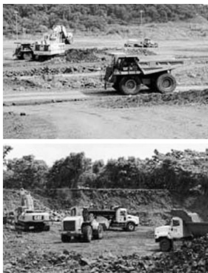
Figura 8. Maquinaria en trabajos de excavación
