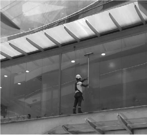
Figura 47. Limpieza de fachadas
