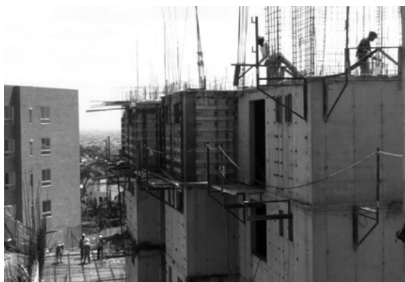
Figura 12. Obra en proceso
