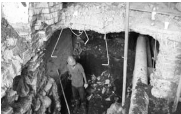
Figura 24. Trabajos de reconstrucción
