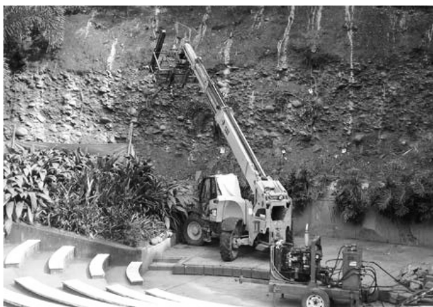
Figura 15. Obras, estructuras de retención, La Tertulia
