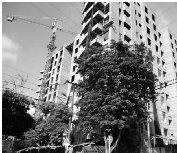
Figura 34. Edificio en construcción
