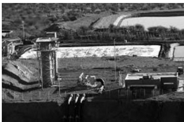
Figura 7. Planta de biogás de relleno sanitario Loma Los Colorados
