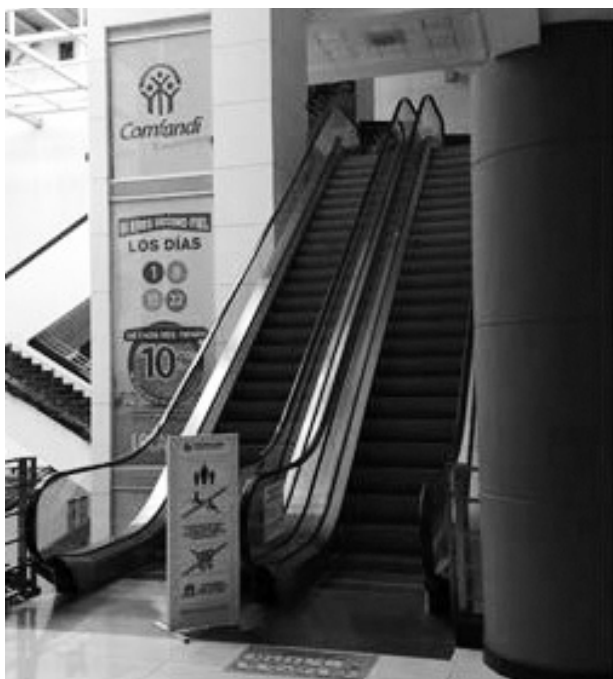
Figura 20. Mantenimiento de escaleras eléctricas
