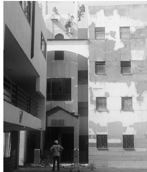
Figura 42. Reparación y mantenimiento de fachadas
