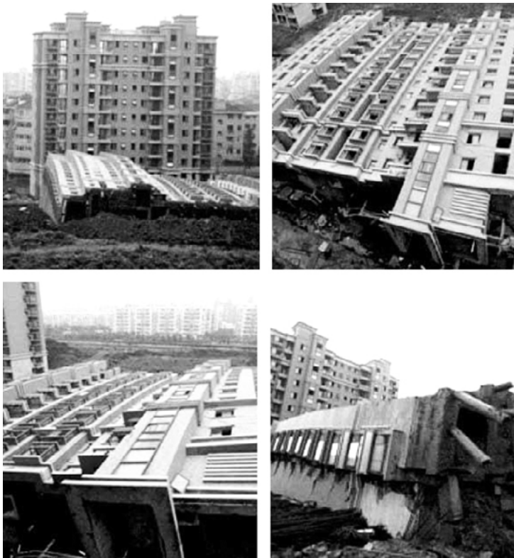
Fotografías de referencia. Desplome de edificio en la ciudad de Shanghai, junio de 2009.
