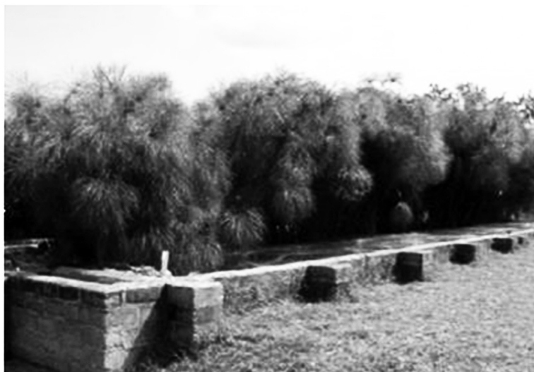
Fotografía 8. Humedal para el tratamiento de aguas residuales
