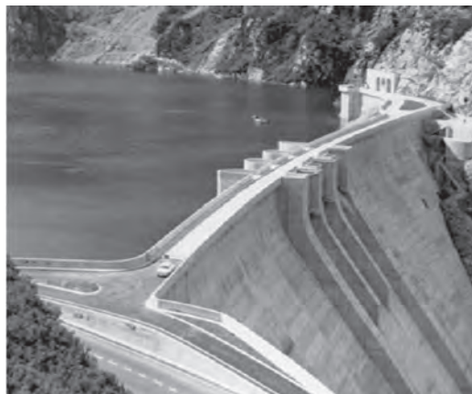
Figura 2.2 Central hidroeléctrica de agua embalsada [14]
