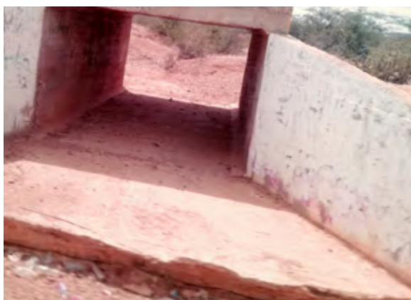
Vista lateral del puente sin río. La Guajira, Julio de 2019. Fotografías por Julián González.
