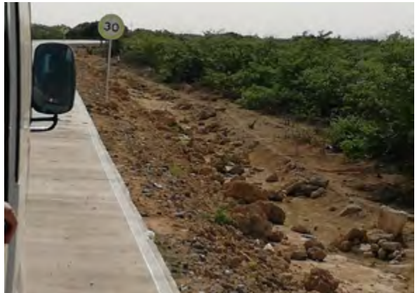
Vista de las nuevas vías que conectan la zona de expansión hotelera con la ciudad de Riohacha. Julio 2019.
