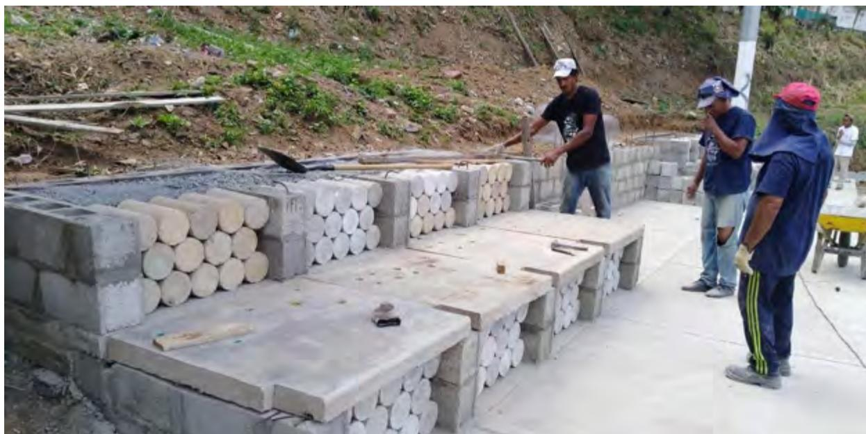
**Figura 113.** Gradería filtrante autoconstruida, caso Yumbo.
