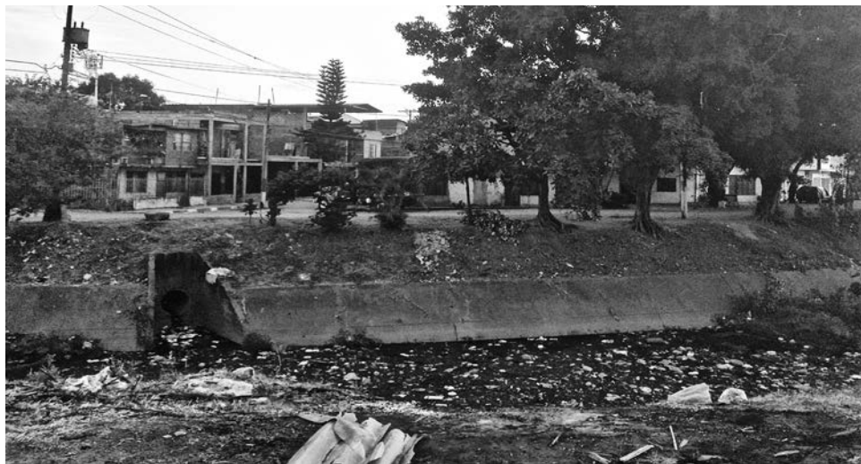
Figura 1.1 Fotografía canal de aguas lluvias sector “La Granja”. Límite de las comunas 13, 15 y 16.
