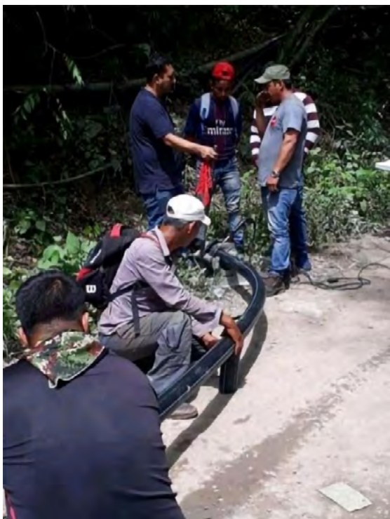
Imagen 14. Conducción de mangueras desde la serranía del Perijá a El Mirador y Tierra Grata
