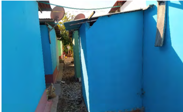
Imagen 8. Adecuaciones de viviendas en el ETCR Pondoers, 2019
