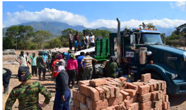
Imagen 2. Construcción en la ZVTN Pondoers
