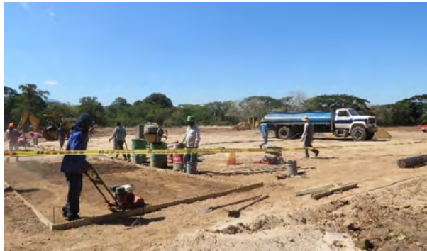
Imagen 1. Construcción en la ZVTN Pondoers
