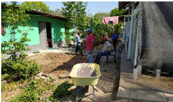
Imagen 7. Adecuaciones de viviendas en el ETCR Pandores, 2019
