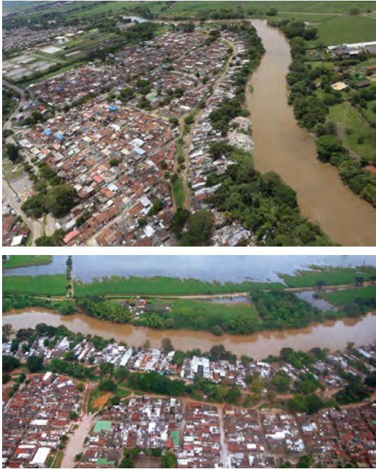
Figura 19. Asentamientos en el Jarillón
