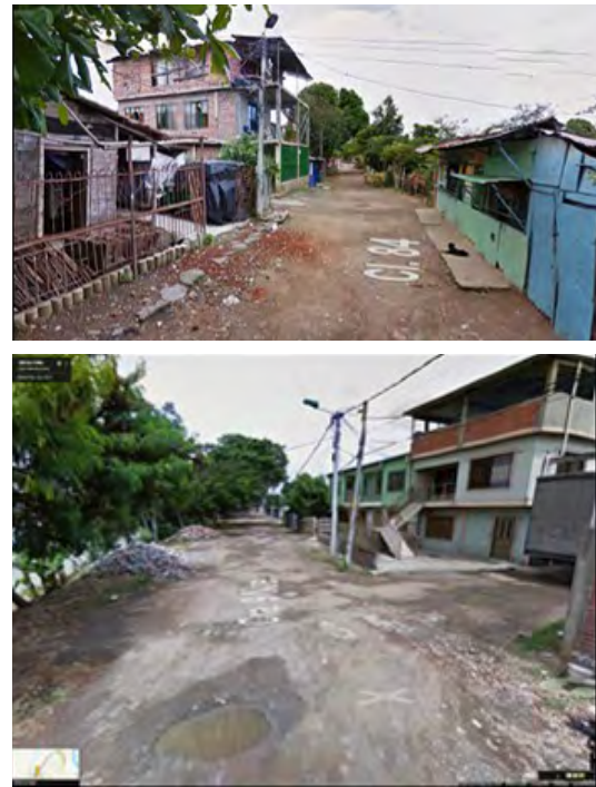
Figura 22. Construcciones al lado del Jarillón
