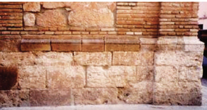
Pátina de suciedad en bloques de calizas
