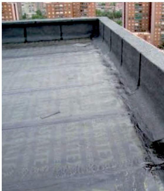
Figura 5.21 Colocación de la tela asfáltica
