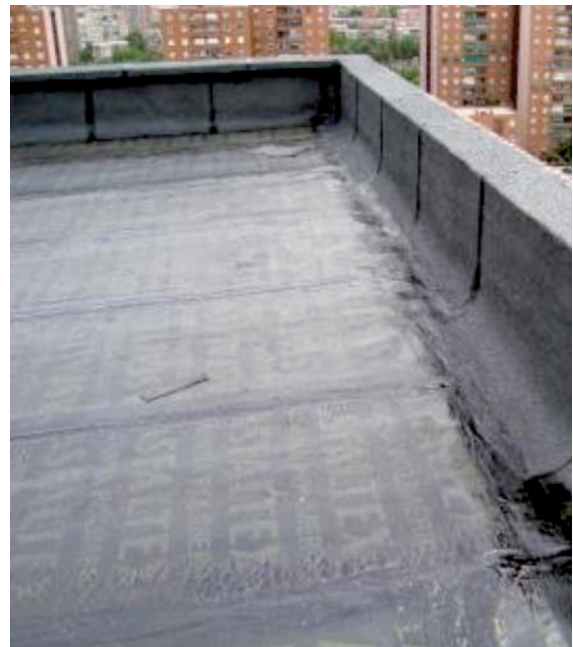
Figura 5.21 Colocación de la tela asfáltica
