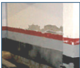
19. Fuente: Curso patología de la construcción
